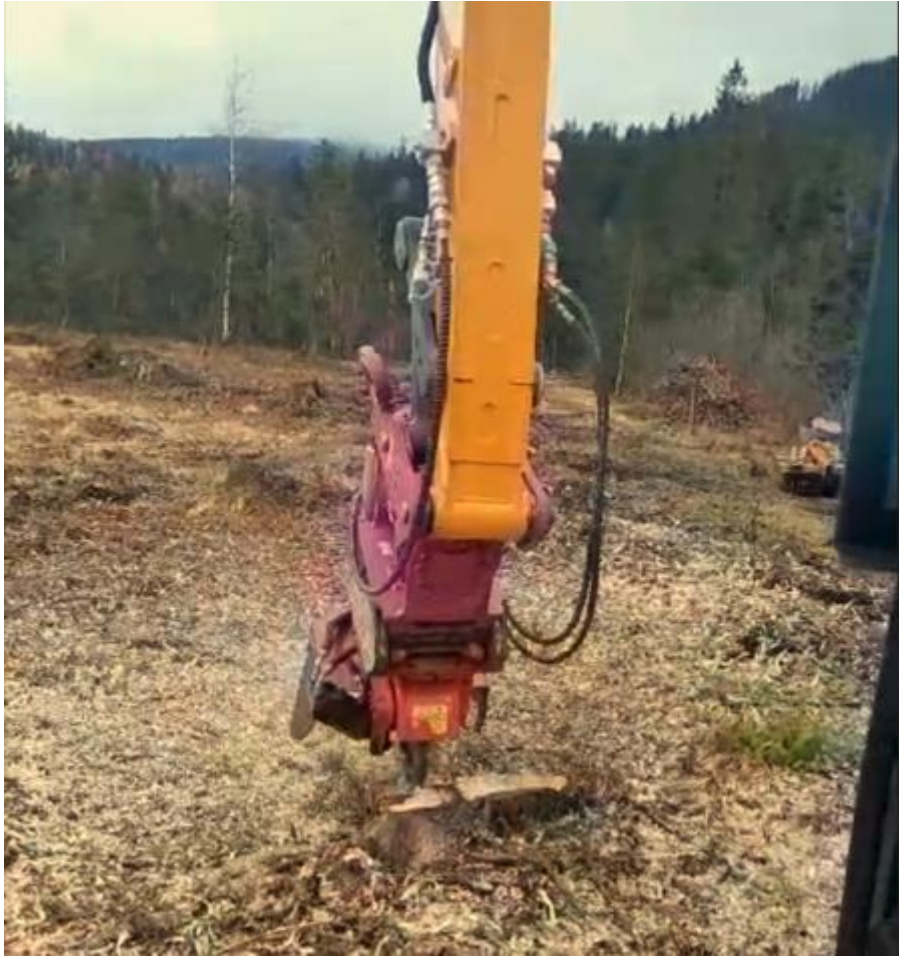
Abbildung 4: Fräsen der Wurzelstöcke mit einer Baumfräse
