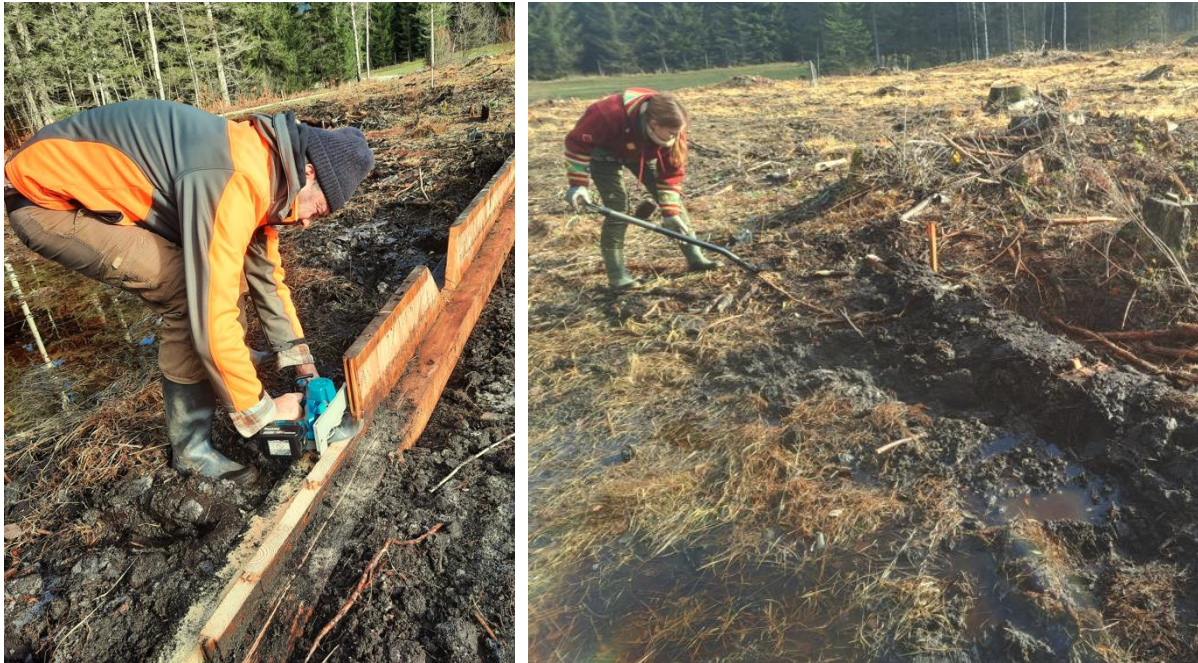
Abbildung 8 u 9: Kürzen der Spundwände und Abdecken mit Bodenmaterial
