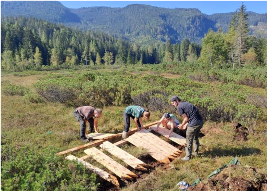
Abbildung 16: Zusammensetzen der Spundwände vor Ort.
