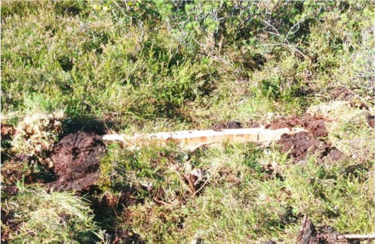
Abbildung 18: Spundwände wurden in der Mitte bodennah abgesenkt, damit dort ein Überlauf entsteht.
