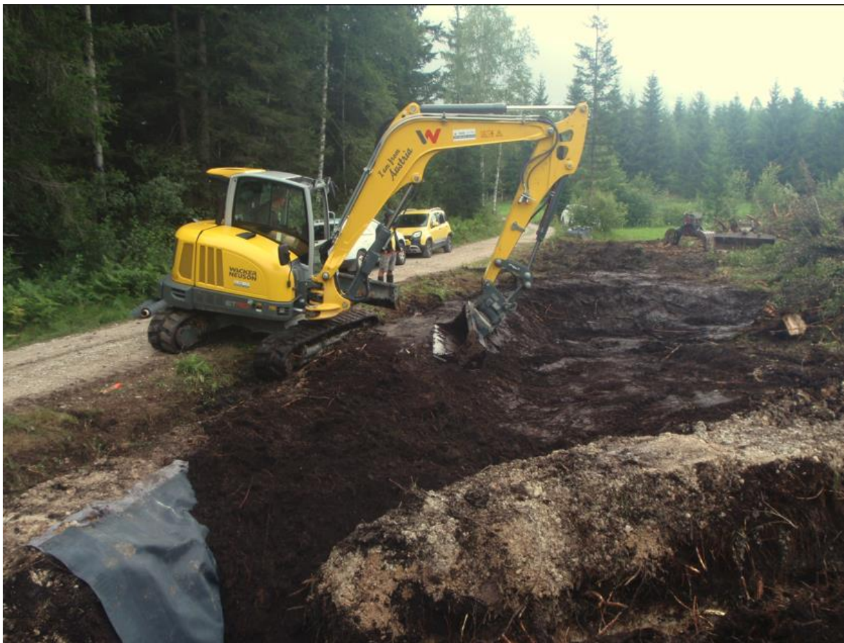
Abbildung 2: Anfertigen des Spitzgrabens mit Damm und eingearbeiteter Folie auf dem Moor zugewandten Seite.
