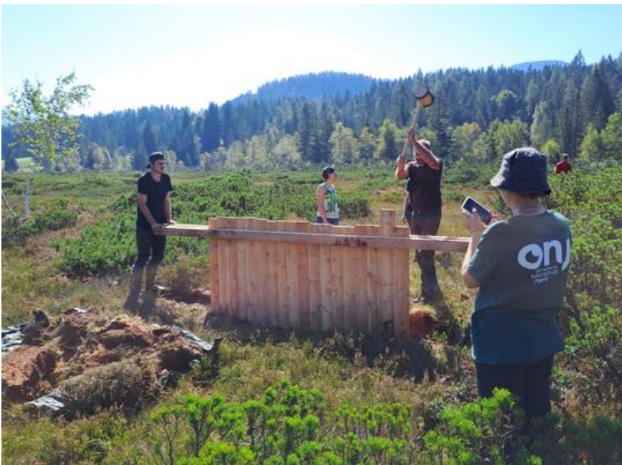
Abbildung 17: Einschlagen der Spundwände.
