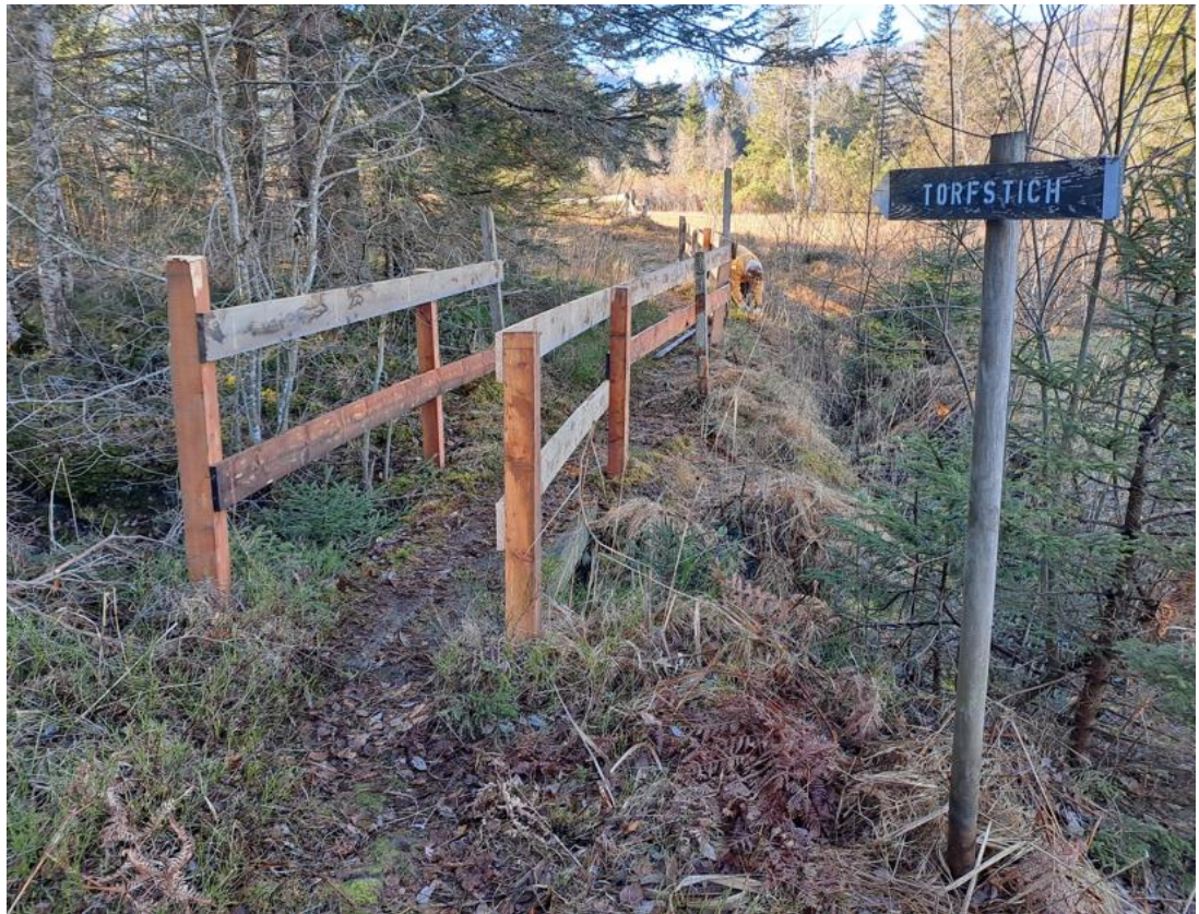
Abbildung 14: Neu errichtetes Geländer im Bereich des Informationspunktes „Torfstichkante“
