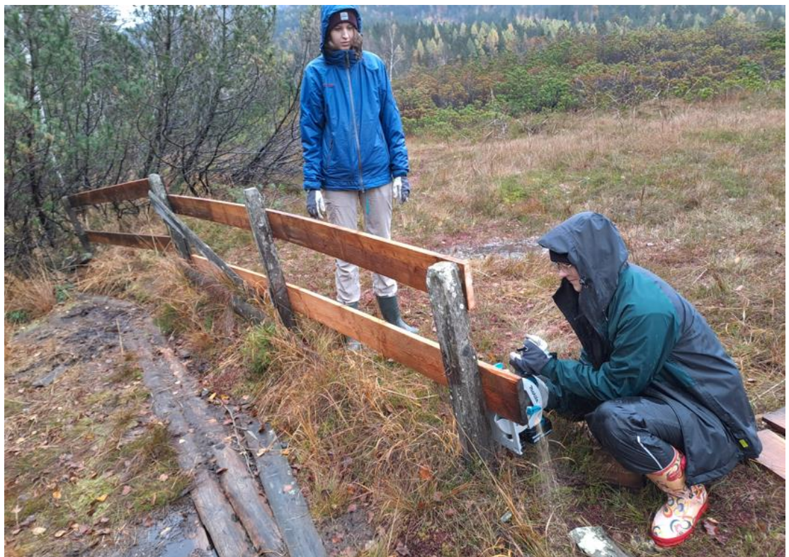
Abbildung 15: Teilweise konnten die alten Pfosten noch genutzt werden. Bretter wurden ausgetauscht.
