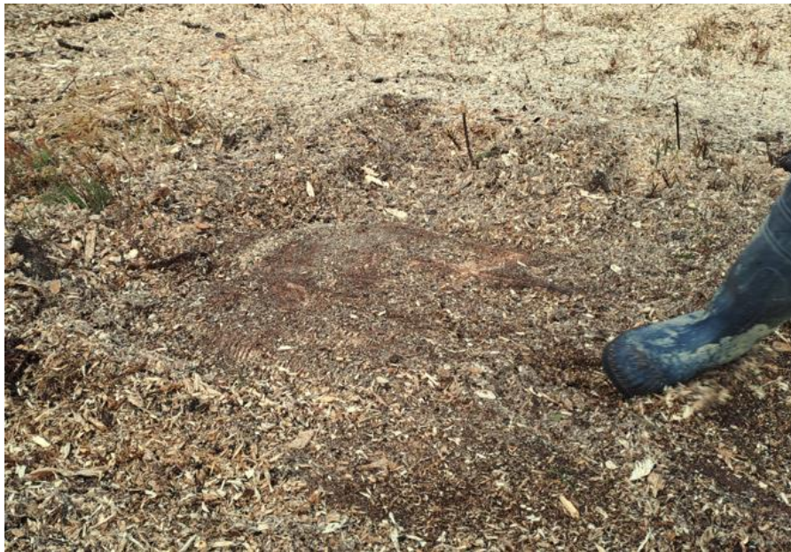
Abbildung 5: Bodengleich gefräster Wurzelstock
